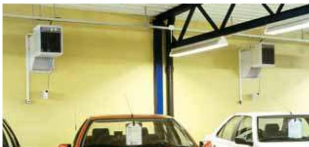
Камера смешения дает возможность сочетать обогрев с вентиляцией. Она обеспечивает режим энергосбережения, когда соотношение наружного и рециркулируемого воздуха поддерживается в нужной пропорции.
