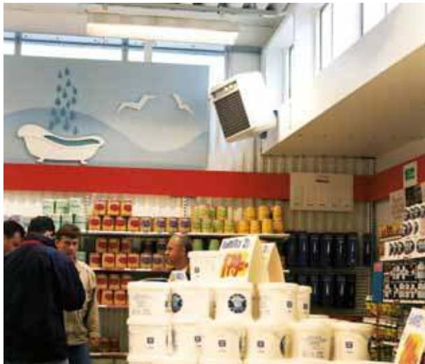
Монтажная скоба, входящая в комплект поставки, дает возможность выбирать необходимое направление потока воздуха, чтобы обеспечить наилучшее распределение тепла.
