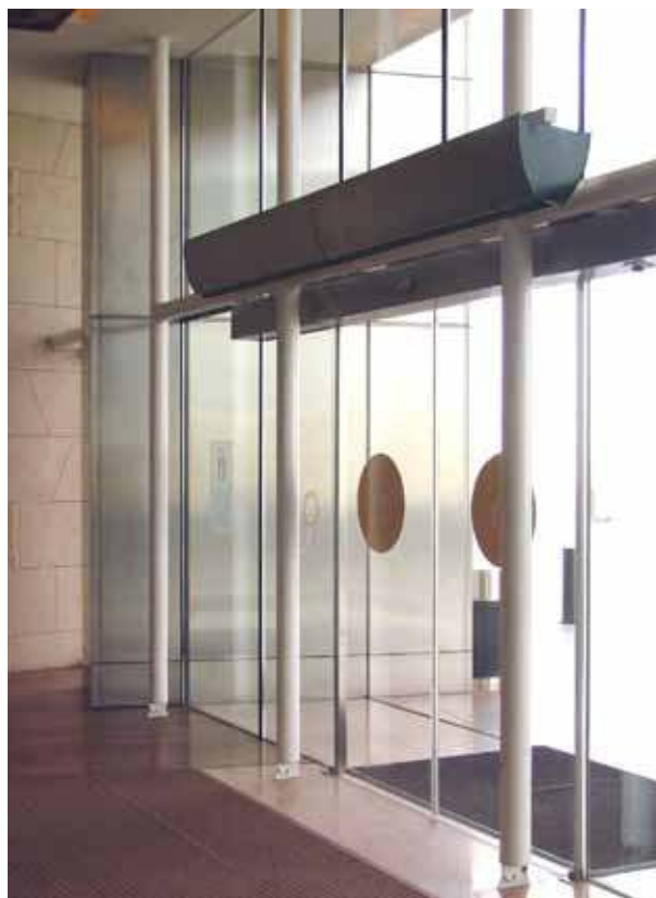
В широких проемах несколько завес при помощи соединительного комплекта устанавливаются вплотную друг к другу так, чтобы поток воздуха был непрерывен.
